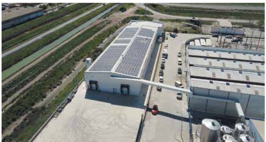
Cubierta de paneles solares de las instalaciones de Lebrija.
